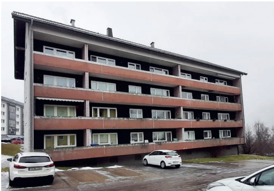
Stalterstr. 60: Westseite - unten die geplanten Balkonanlagen
